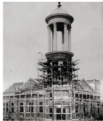
Construção do templo
