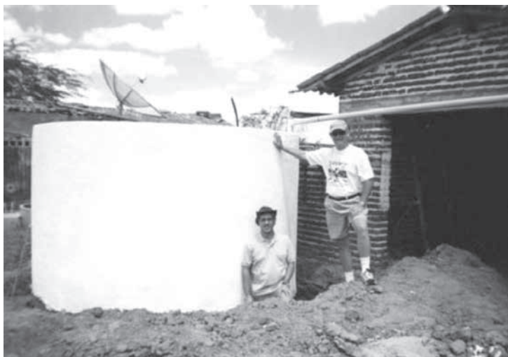
Projeto Sertão: construção de cisterna em São Mamede, PB
